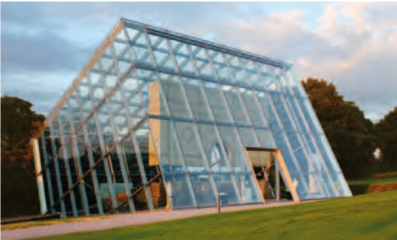
Abb. 14: Seit seiner Nominierung zum Welterbe war der Obergermanisch-Raetische Limes großen Veränderungen unterworfen, die zumeist darauf abzielten, das Denkmal besser sichtbar zu machen. Das neu errichtete Schutzhaus über dem Dalkinger Tor ist nur ein Beispiel dieser Veränderungen der letzten Jahre.
