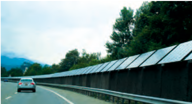
Abb. 13: Solaranlage an einer Schallschutzwand.
