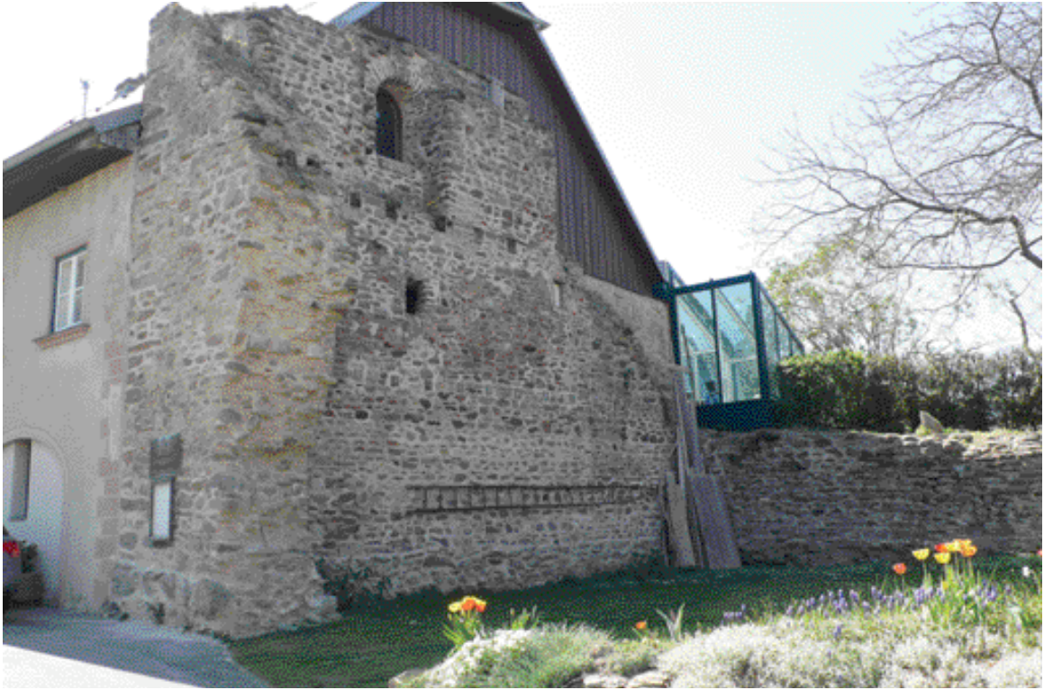
63. The walls of the late Roman watch-tower at Bacharnsdorf (Austria) are still standing up to the second storey Die Mauern des spätrömischen Wachturms in Bacharnsdorf (Österreich) sind bis zum zweiten Stock erhalten
