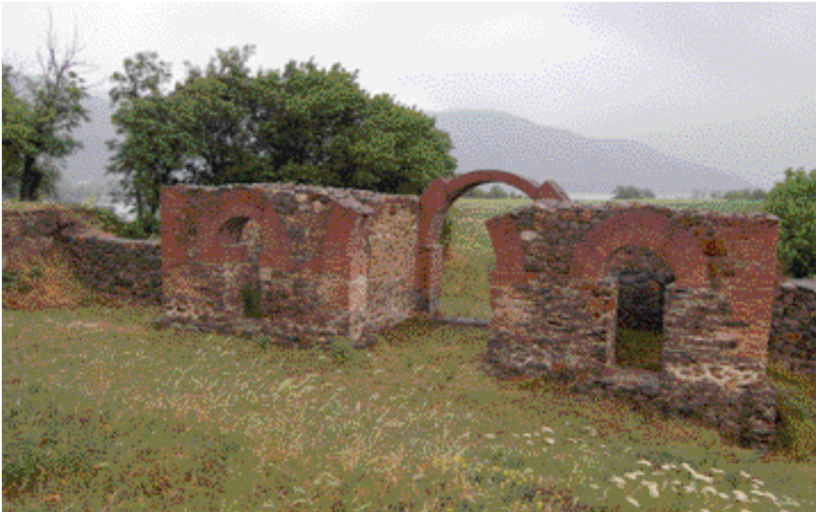
118. The remains of the eastern gate of the fort Diana near Karatas in Serbia were restored Das Ruinen des Osttors des Kastells von Diana bei Karatas wurden in Serbien konserviert
