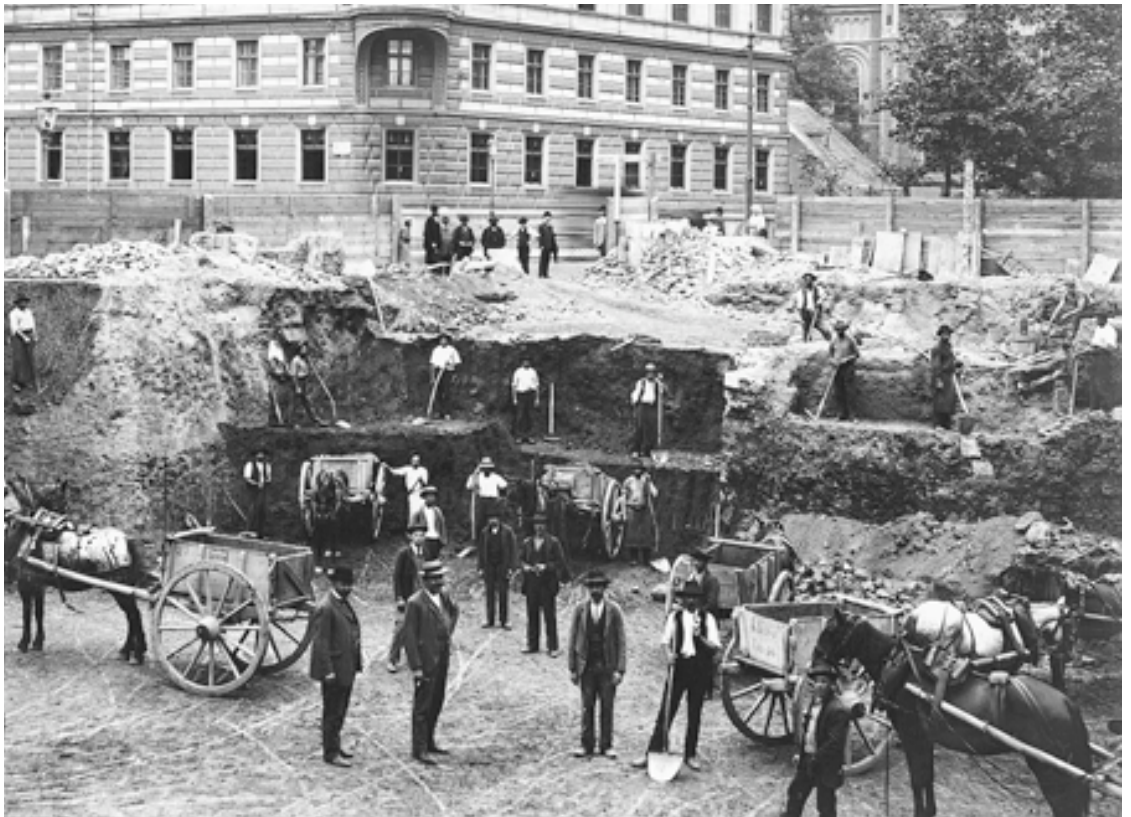
102. Excavations started in Vienna during the major construction work removing the former city defences in the second half of the 19th century Vor mehr als 100 Jahren begannen die Ausgrabungen in Wien während der massiven Umbauten bei der Entfernung der alten Stadtbefestigungen
