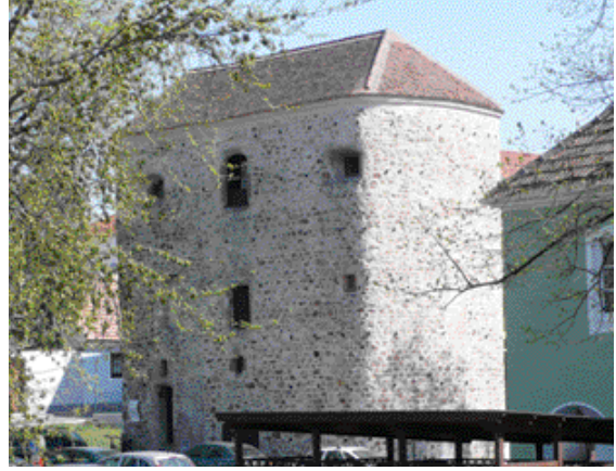
89. Close to the bicycle road along the Danube in Tulln (Austria) a late Roman U-shaped tower is preserved Nahe dem Donauradweg in Tulln (Österreich) ist ein spätrömische U-förmige Turm erhalten
