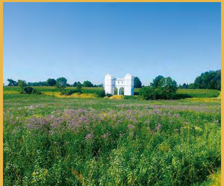
▶ Blick von Nordwesten auf Tor und Kastellfläche.
