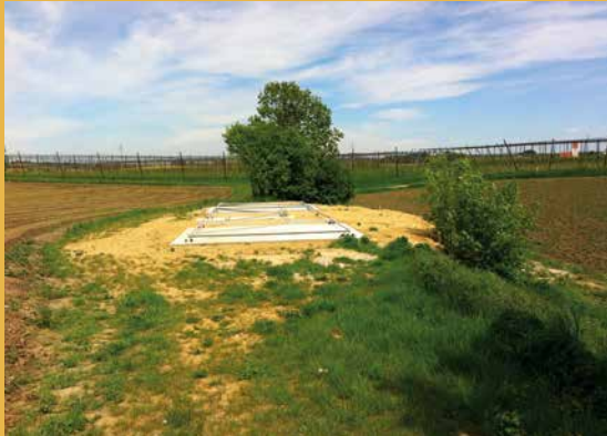
◀ Bodenplatte über den Fundamenten des Nordosttors.
