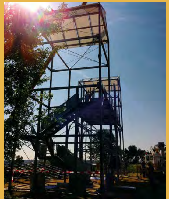
▲ Die Stahlkonstruktion des Tors mit der Besucherplattform.
