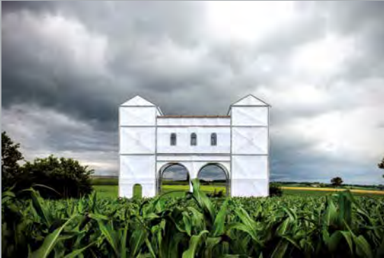
Titelbild: Der Nachbau des Nordosttors von Kastell Celeusum bei Pförring besteht aus einem Stahlgerüst mit textiler Bespannung.
