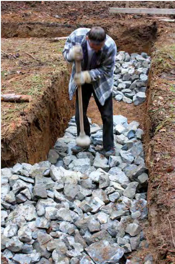
◀ Verfestigung der Rollierung aus Bruchsteinen im Turmfundament.
