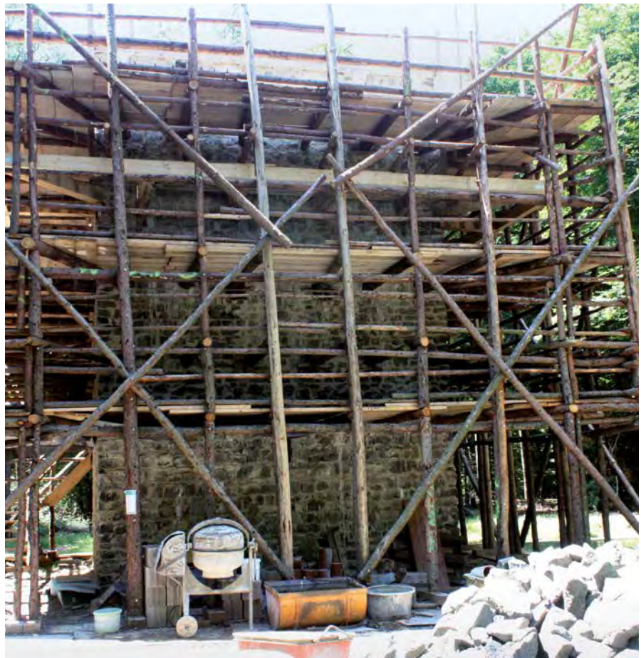
▶ Der Turm mit dem Holzgerüst während des Baus.
