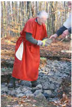
▲ Legen der Ausgleichsschicht auf der Fundamentoberkante im Übergang zum aufgehenden Mauerwerk.
