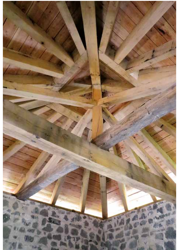
▶ Blick in die Holzkonstruktion des Dachstuhls.
