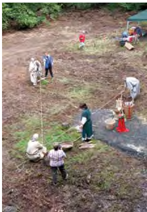
▲ Abstecken und Markieren des Turmfundaments.
