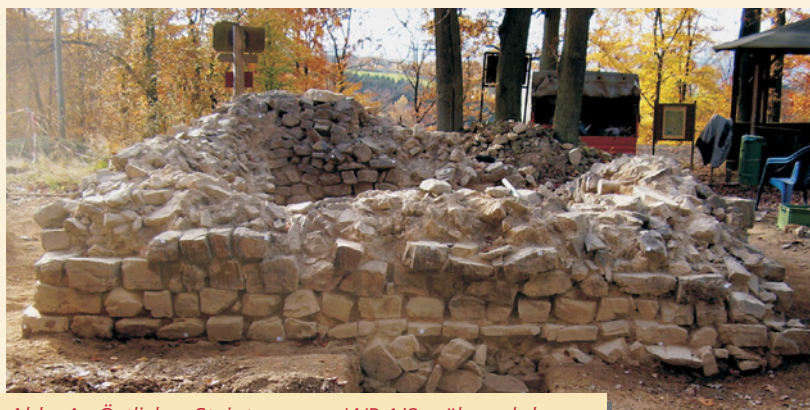
Abb. 4 : Östlicher Steinturm von WP 1/8 während der Nachgrabungen im Jahr 2006/07 mit steingerechter photogrammetrischer Aufnahme der Nordostmauer.
