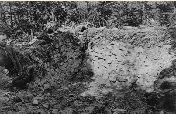
Abb. 1 Östlicher Steinturm von WP 1/8 im Jahr 1894 nach der Freilegung durch die Reichslimeskommission, als die Mauer rund herum noch bis zu 1,50 m hoch aufrecht stand.
