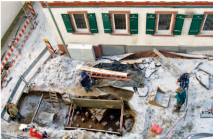
Grabungsschnitte im Rahmen der Kanalbauarbeiten gewähren - etwa 2 m unter heutigem Niveau - Einblicke in das Kastellbad von Bad Ems mit Überresten einer Mauerecke und den zum Teil noch aufrecht stehenden Ziegelpfeilern der Unterbodenheizung ( hypocaustum ).
