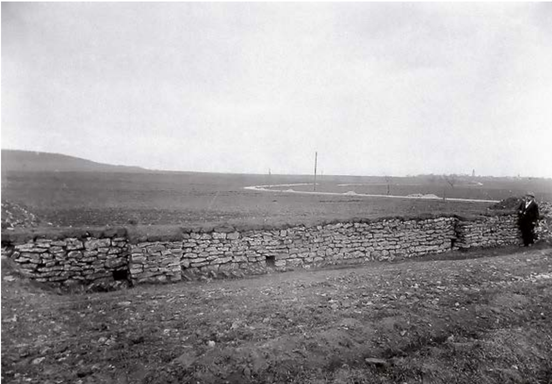
Raetische Mauer bei Burgsalach in Mittelfranken um 1920.
