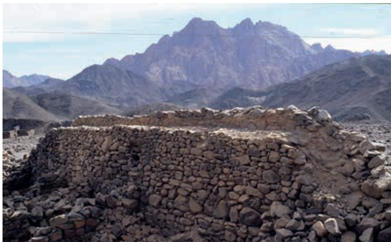
84. The parapet walk of Umm Balad Le chemin de ronde d'Umm Balad
