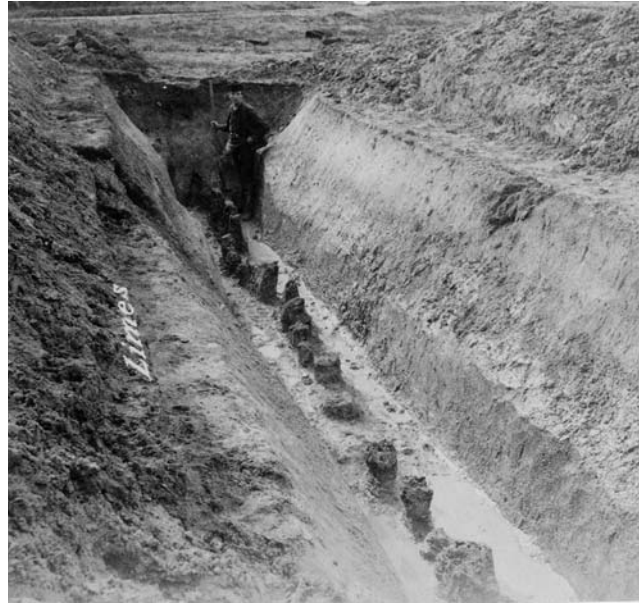
48. The timber palisade in Germany, excavated in 1894 Die Holzpalisade in Deutschland, 1894 ausgegraben
