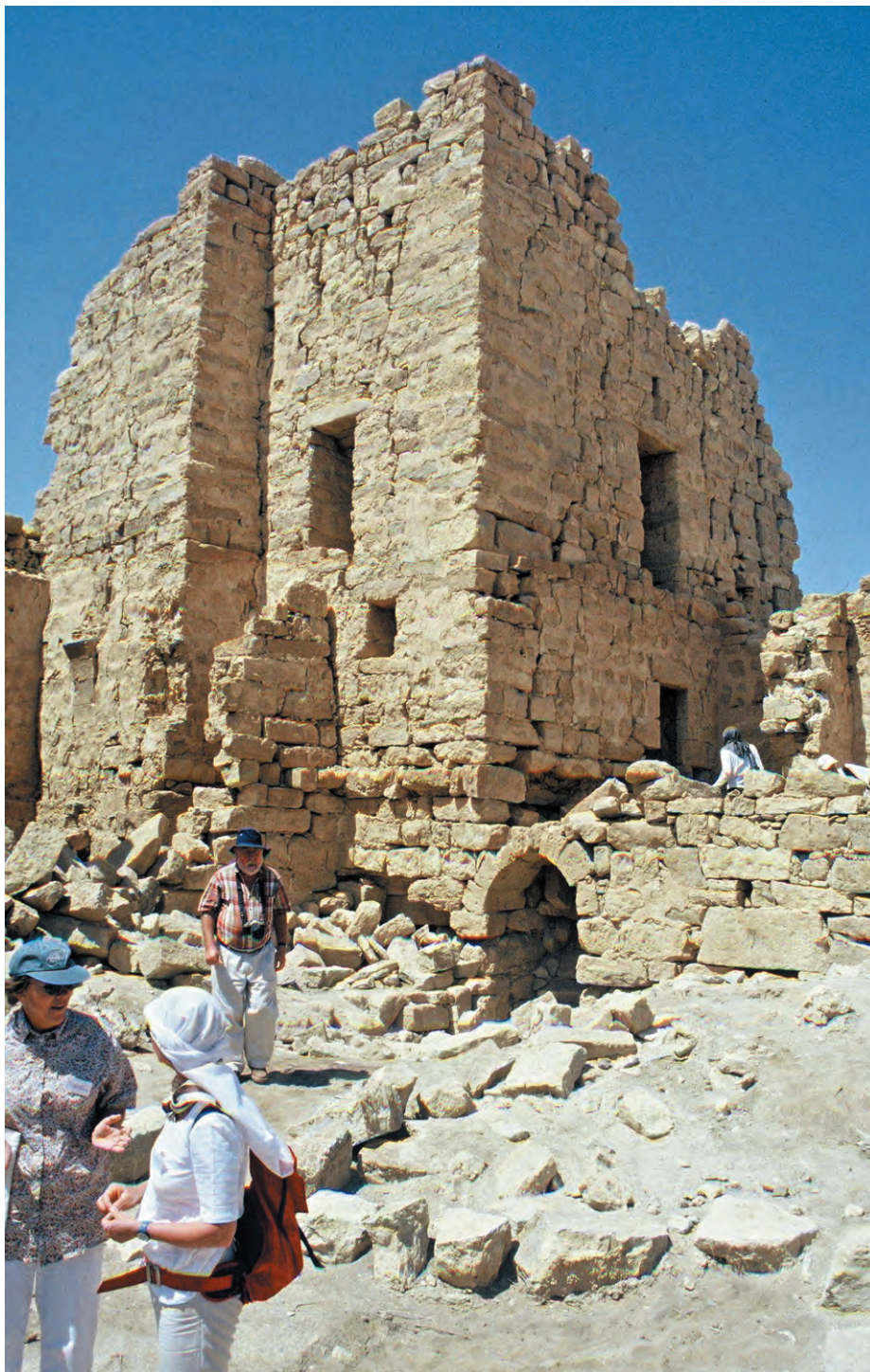
Fortification and corner tower at the fortress of Gasr Bishr (Jordan) Befestigungsanlage und Eckturm des Kastells Gasr Bishr (Jordanien) Pevnosť a náročná veža kastela Gasr Bishr (Jordánsko)
