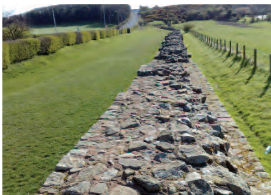
80. The broad wall at Heddon-on-the-Wall looking east Der breite Wall bei Heddon-on-the-Wall, Blick nach Osten La muraille large à Heddon-on-the-Wall, vue vers l'est
