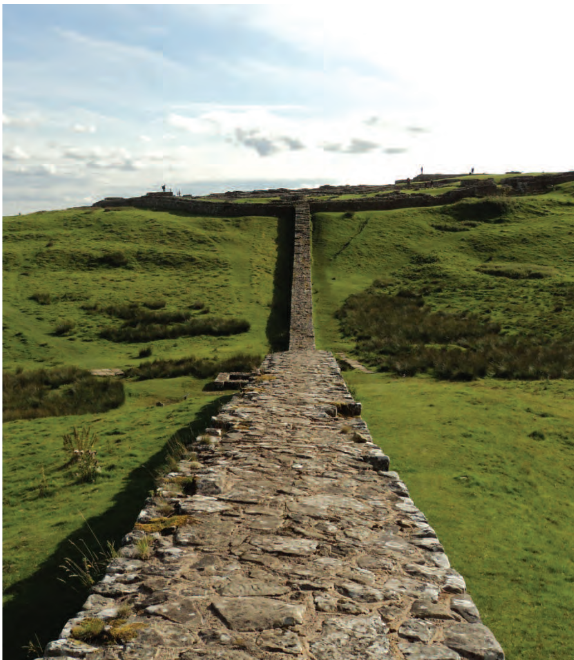
3. The fort at Housesteads on Hadrian's Wall with the Knag Burn gate in the foreground Das Lager von Housesteads am Hadrianswall, im Vordergrund das Knag Burn Tor Le fort de Housesteads sur le Mur d'Hadrien avec la porte de Knag Burn au premier plan
