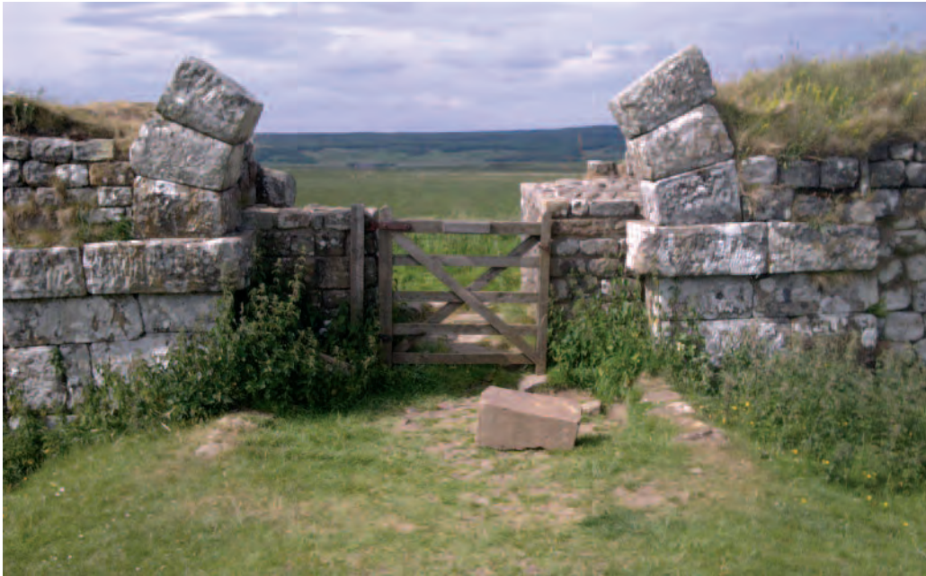
95. The north gate of milecastle 37 (Housesteads) Das Nordtor von Meilenkastell 37 (Housesteads). La porte du nord du fortin 37 (Housesteads)
