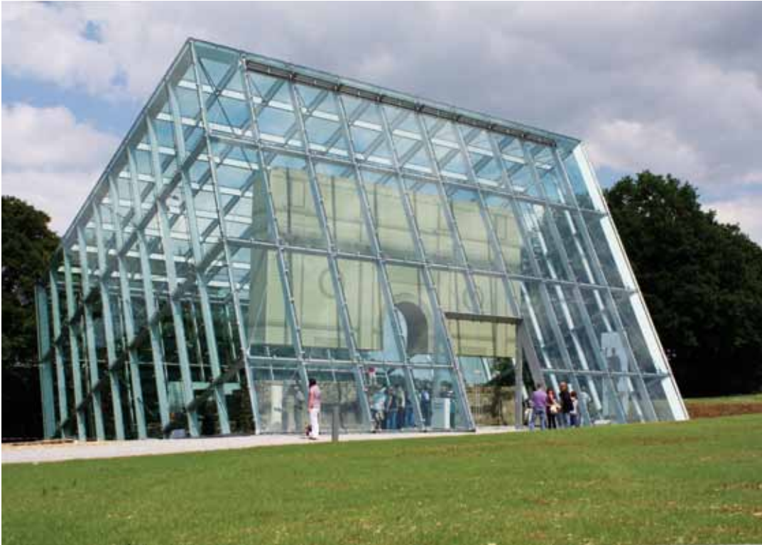
Rainau-Dalkingen. Schutzhaus aus dem Jahre 2010 über der Ruine des mehrphasigen Limestores mit Visualisierung des Bogens.
