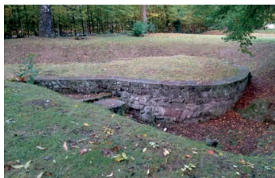
Saarbrücken. Konservierte Mauern eines Kastelleckturms.
