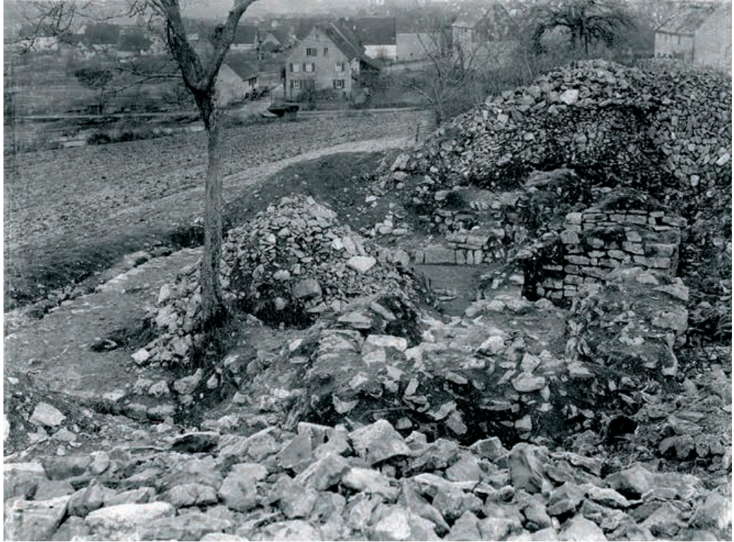
Abb. 8 Ausgrabungsbefunde, wie hier im Kastell von Osterburken, sind nahezu die einzige Quelle für unser Verständnis und den Nachbau der einzelnen Limesbestandteile.
