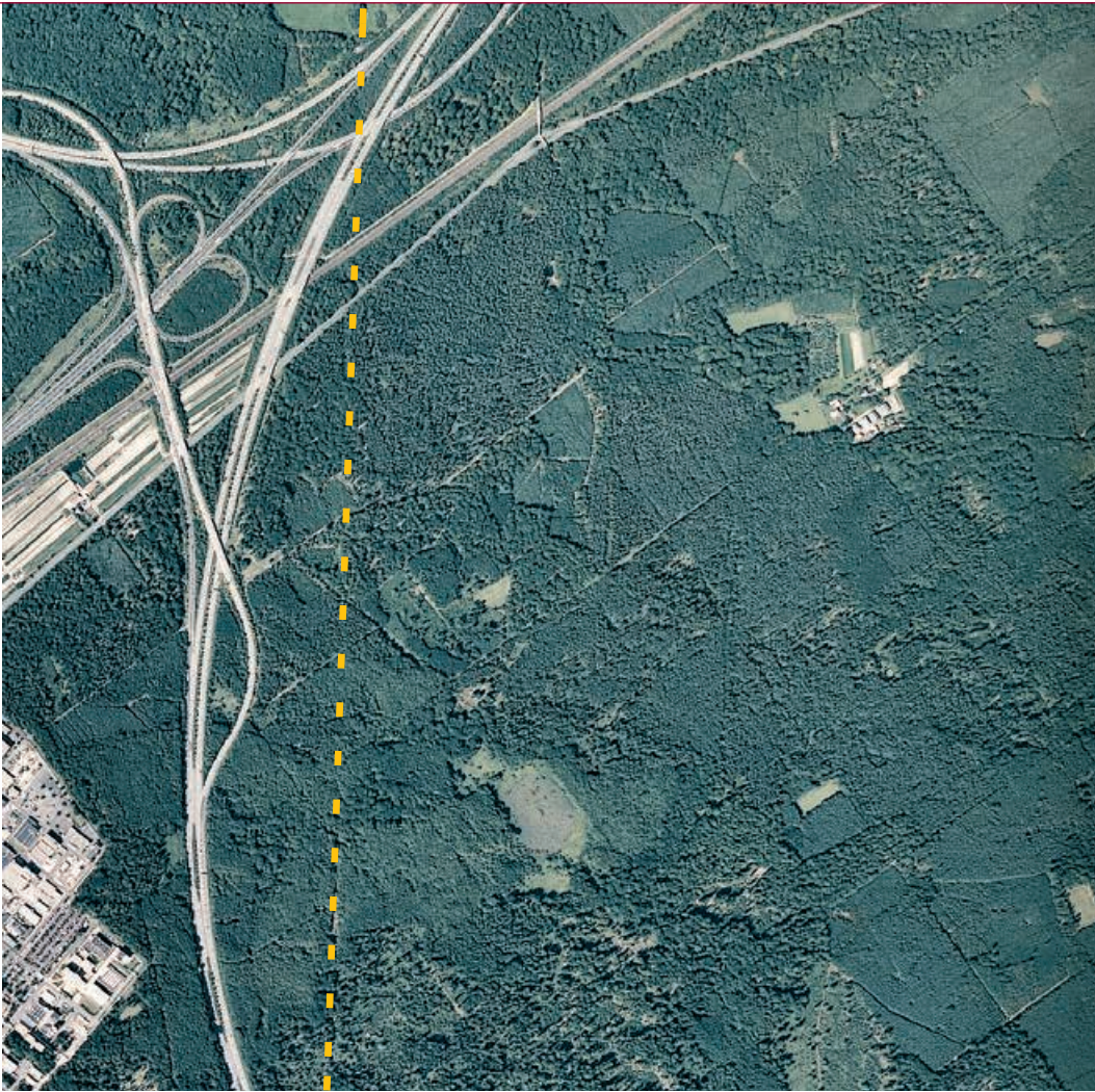
Abb. 12 Hanau-Wolfgang. Beim Bau des Hanauer Kreuzes werden zwischen 1976 und 1978 an mehreren Stellen die Reste der Sperranlagen sowie die Turmstelle WP 5/10 zerstört. Der Verkehrsknotenpunkt von A 45 und A 66 zwischen den Naturschutzgebieten „Rote Lache von Wolfgang“ und „Erlensee bei Erlensee“ beeinträchtigt außerdem einen ökologisch sensiblen Bereich. Mit dem Verlust von Denkmalsubstanz geht oft wertvoller Lebensraum für Pflanzen, Tiere und Menschen verloren.
