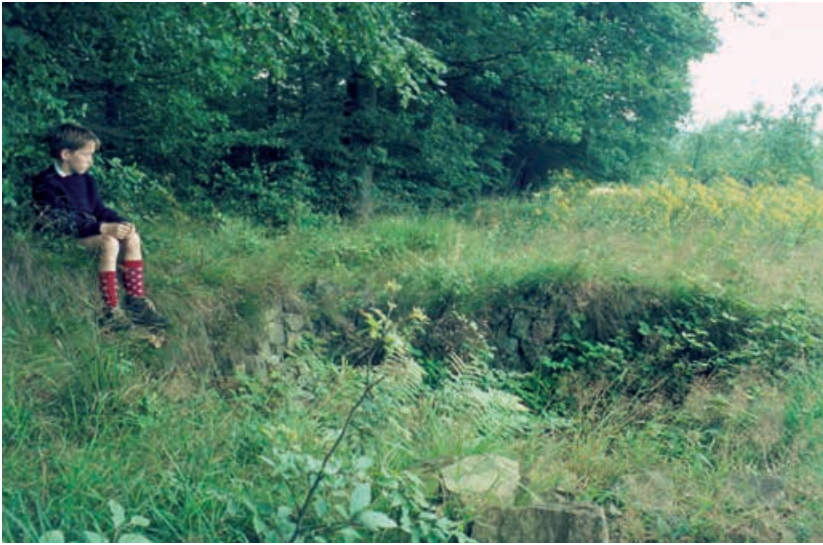
Abb. 4 Östlicher Steinturm von WP 1/8 im Jahr 1968 unter Bewuchs.
