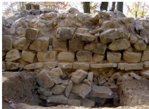
Abb. 13 Östlicher Steinturm von WP 1/8 mit steingenaue fotografometrischer Aufnahme der Nordostmauer außen. Detailfoto mit Fundament.
