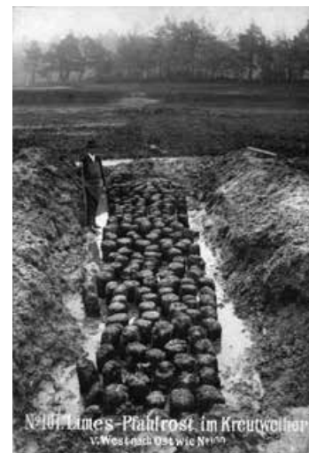
Abb. 1 Kastell Dambach. Fundamentpfähle der Raetischen Mauer im Kreutweiher 1896.
