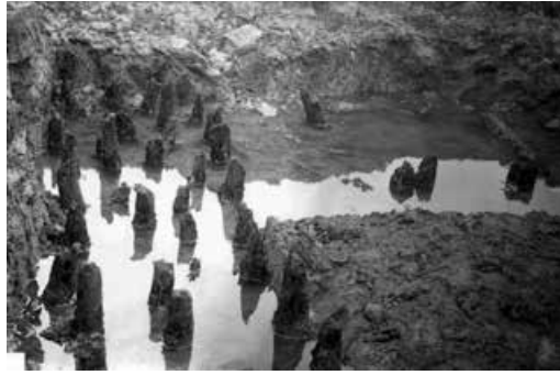
Abb. 4 Gunzenhausen. Pfahlrost in den Altmühlwiesen (Eidam, Limesarchiv der RGK, Ingolstadt).
