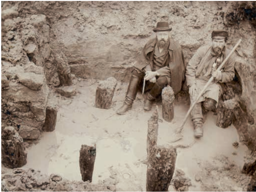
Abb. 5 Pfahlrost der Limesmauer hinter der Unterhambacher Mühle. Dr. Eidam mit einem freiwilligen Helfer 1897.
