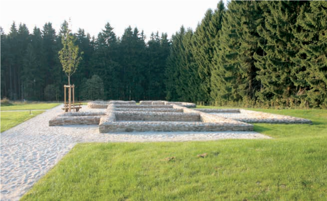
Abb. 19 Kastell „Kleiner Feldberg“ bei Schmittener-Niederreifenberg, Hochtaunuskreis. Kastellbad „Heidenkirche“ nach der Sanierung.
